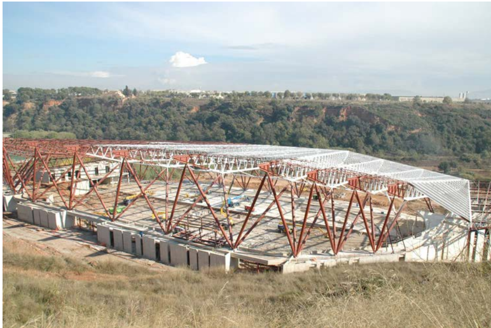
Estat Obra. Foto: Francesc Carrión (Butlletí JAS)
