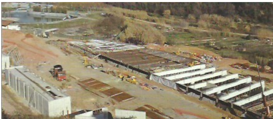
Estat Obra. Foto: Francesc Carrión (Butlletí JAS)
